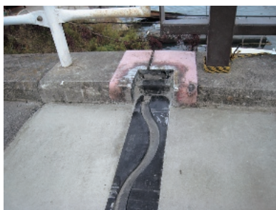
後打ちコンクリート打設
